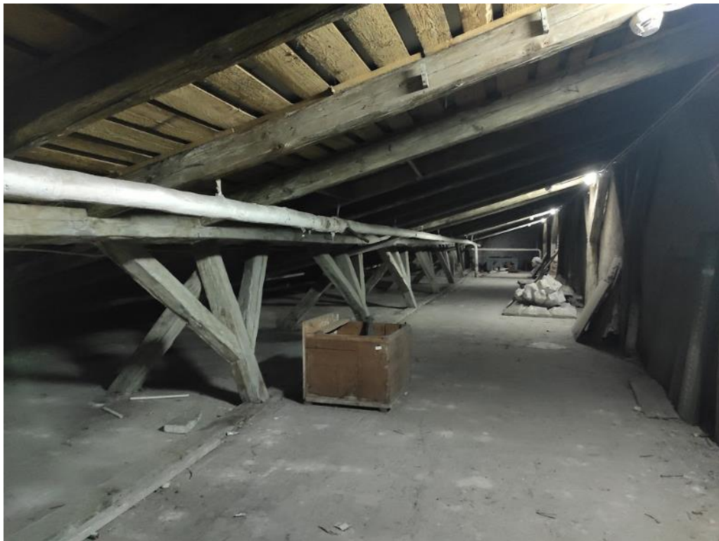
Fotografia nr 3. Widok konstrukcji więźby dachowej.
