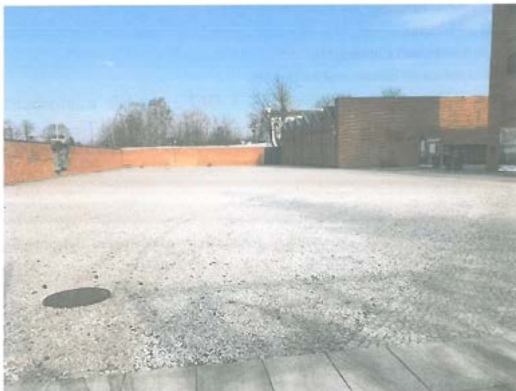
Fotografia 3 Teren w części ogólnodostępnej – plac.
